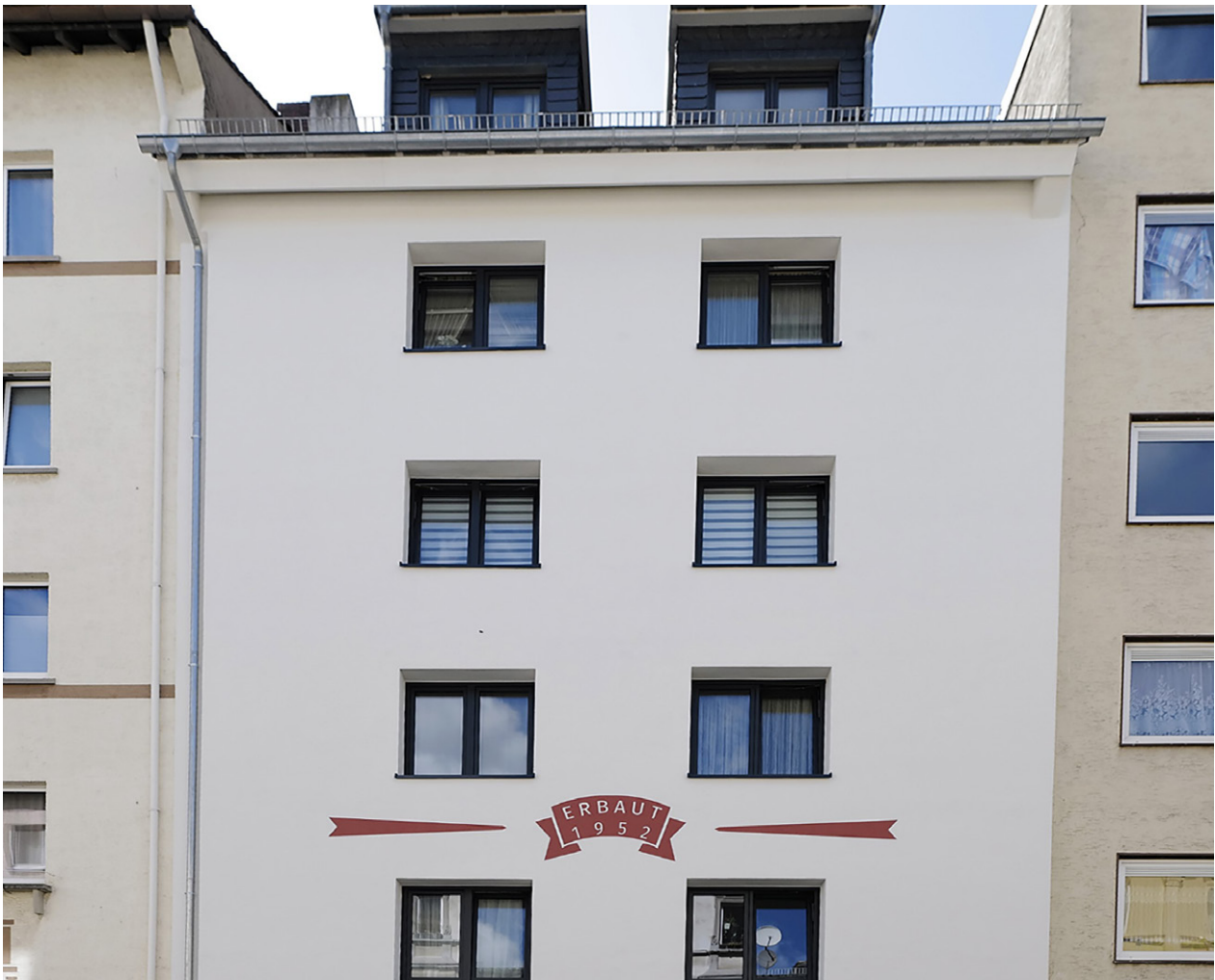
Bild oben: Bettinastraße 18 nach der Sanierung
