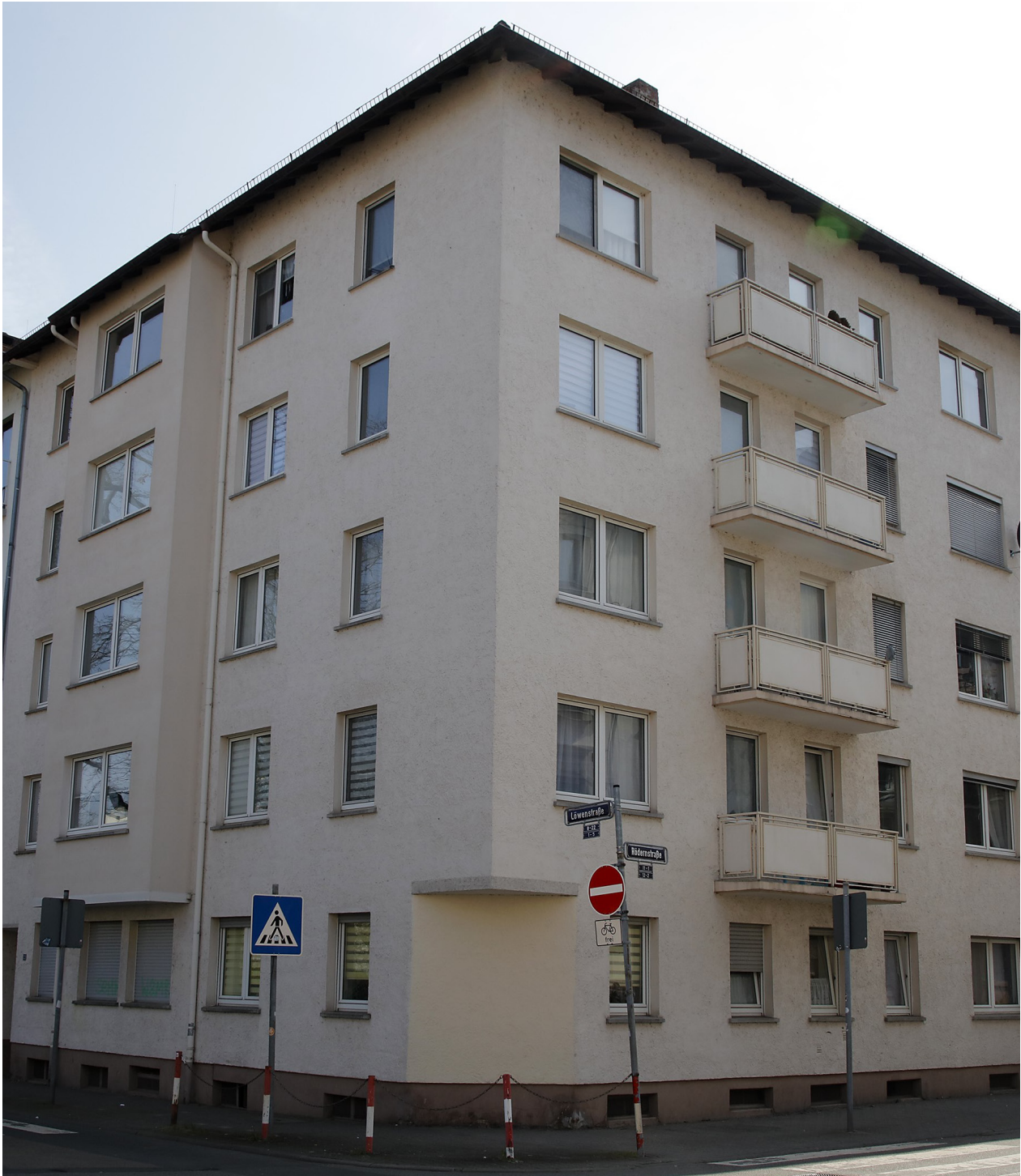
Bild oben: Löwenstraße 22 vor der Sanierung
