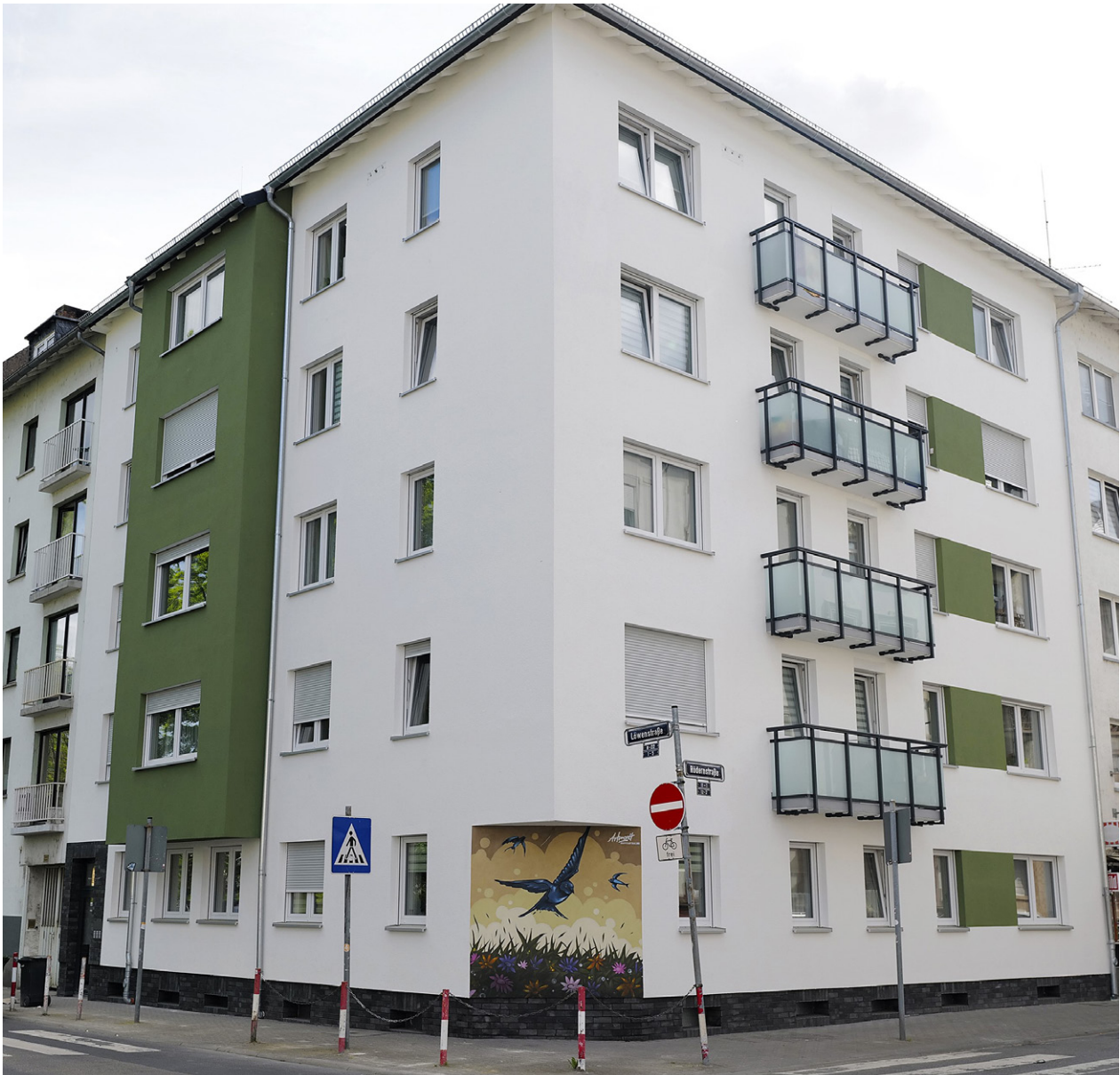
Bild oben: Löwenstraße 22 nach der Sanierung
